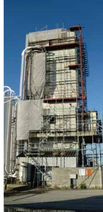
プラント改修工事
