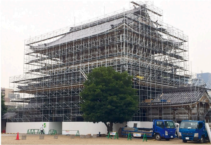
■ 寺院改修工事
