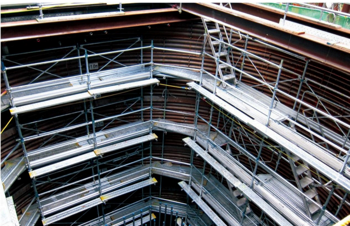
■ 高架橋橋脚工事
