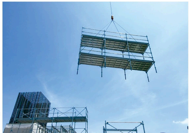
■ 高架橋橋脚工事
