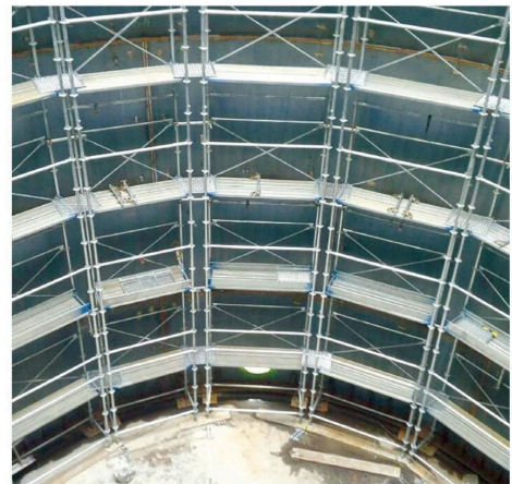
■ サイロ建設工事
