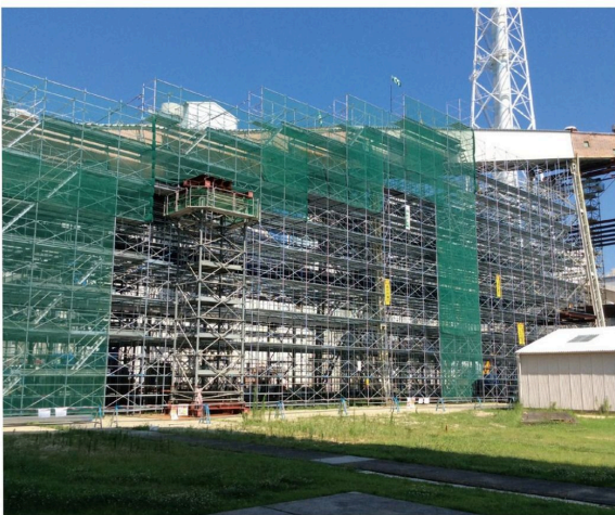
■ 電力発電所補修工事
