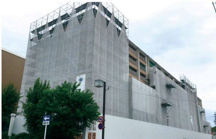
■ マンション改修工事
