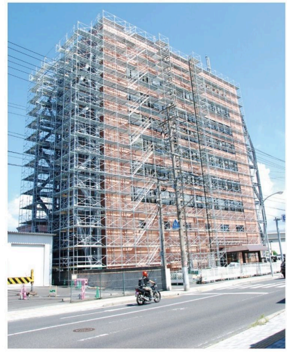
■ 社屋新築工事
