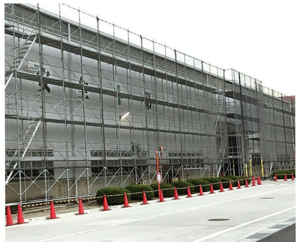
■ 倉庫新築工事
