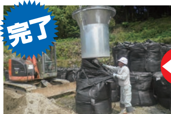
④「瞬作」を抜いて作業完了
