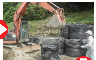
②バケツで「瞬作」に土砂を入れる
